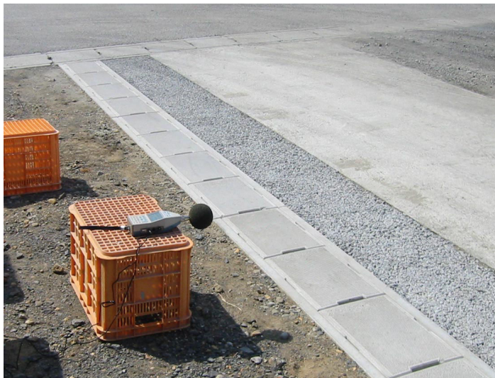
試験状況（箱型U字側溝集水タイプ）
