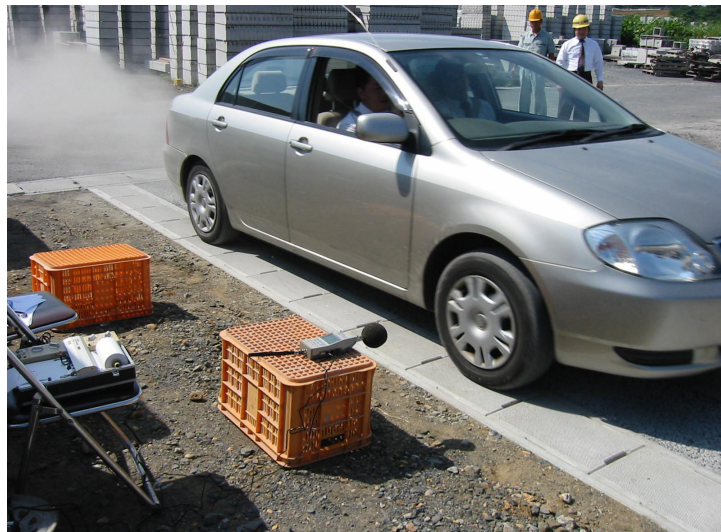
計測状況（箱型U字側溝集水タイプ）
